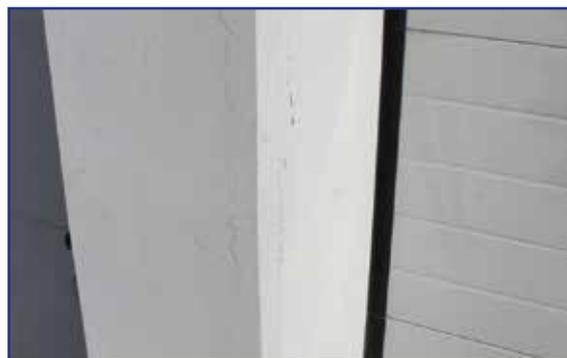
Putzabplatzungen an Wänden und Säulen
