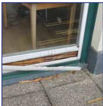
Abgeschlagene, undichte Fenster
