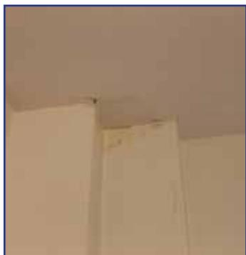
Wasserschäden an der Decke und auf Wänden
