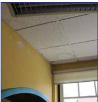
Wasserschäden an der Decke und auf Wänden
