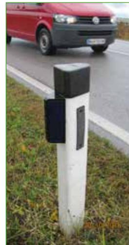
Blaue Reflektoren wurden in Abständen von 30 Metern jeweils alternierend links und rechts des Weges an den Leitpflöcken montiert und sollen das Verkehrslicht blau in Feld und Wald reflektieren, um Tiere abzuschrecken.
